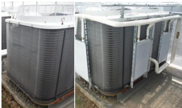
空調室外機に外付式凝縮器『スパコンR』の取付 左:取付前 右:取付後
