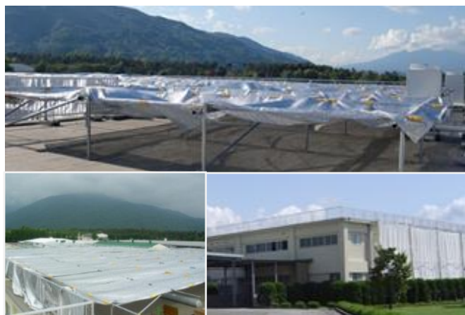
東棟遮光シート (写真上は、今年度初設置の東2-2増設棟)
