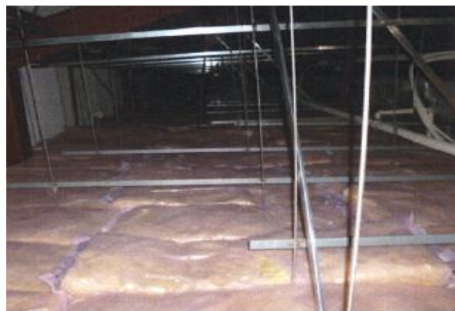
天井裏の断熱(西6・中1・中3前室・中4・中5) (写真は中1号棟)
