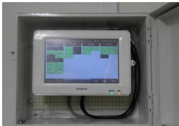
空調機集中タイマー制御パネル 全体の40%を占める90台を制御 (稼働:12/23)
