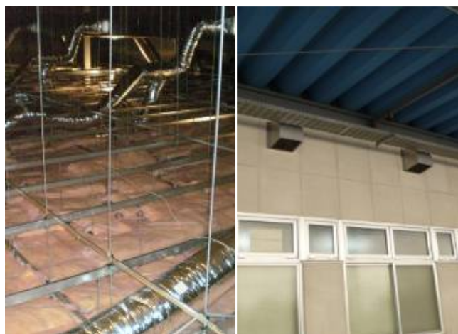
天井裏の断熱／換気
