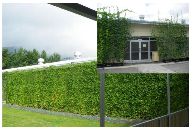
西1・2号棟南側で緑のカーテンを実施
