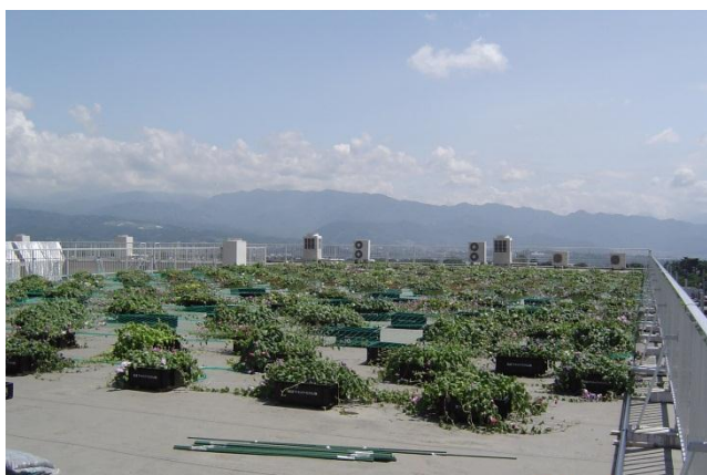
東1号棟で屋上緑化を実施
