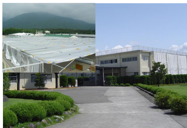
東棟南側・屋上の遮光カーテン
