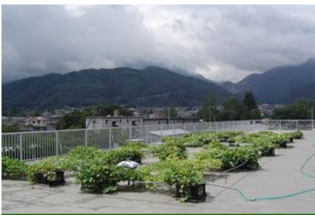
東1号棟で屋上緑化を実施
